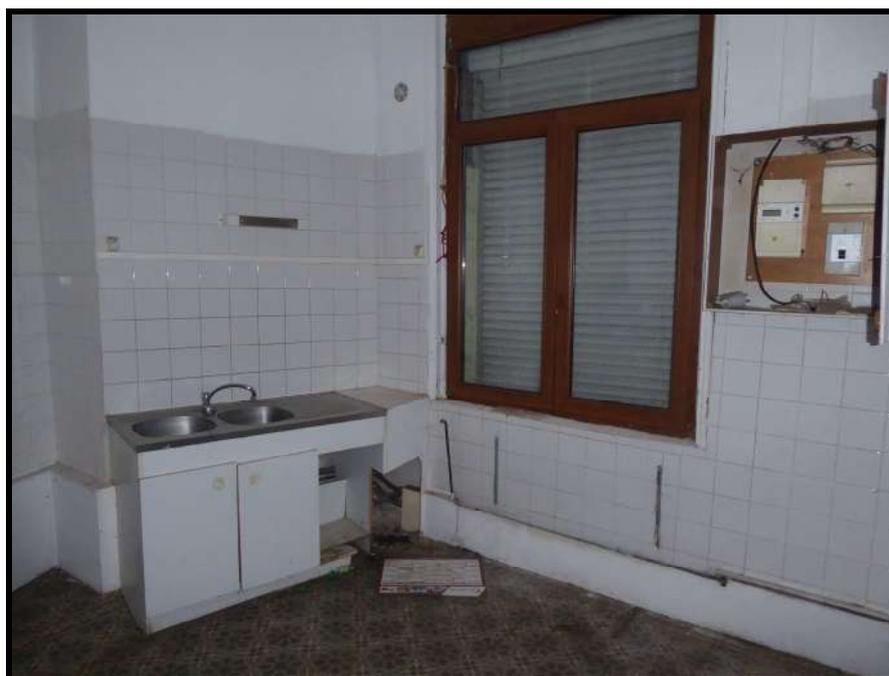
Une fenêtre avec menuiserie pvc double vitrage en état équipée d'un volet mécanique dont la sangle est arrachée.
