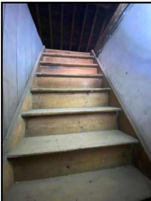
Aux murs de la montée d'escalier, des lamelles de bois côté gauche, du torchis côté droit.
