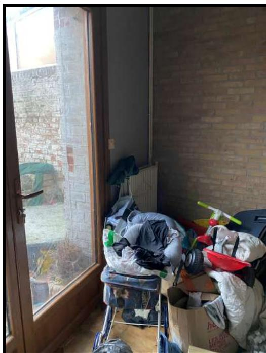
Sur la droite, un radiateur en tôle avec vanne simple.
