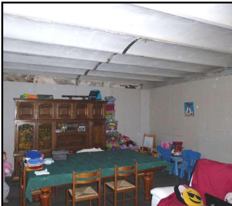
Je constate que le sol se compose d'une dalle béton irrégulière brute.
