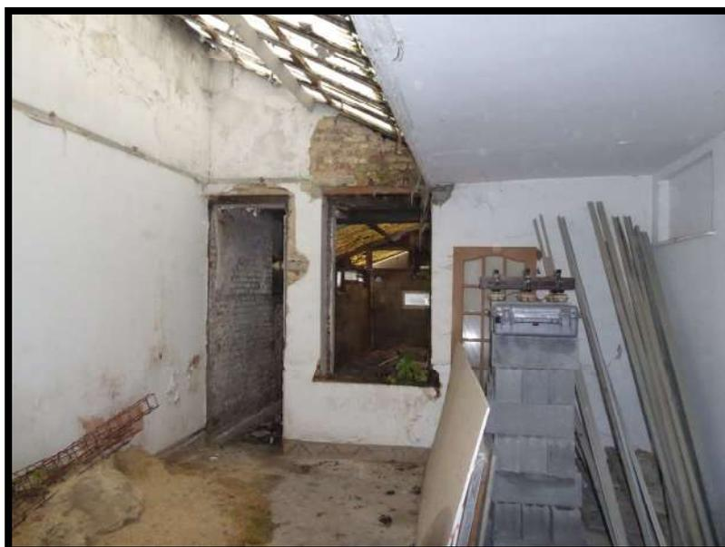
Cette pièce est éclairée par un puits de lumière composé de tôles ondulées remplaçant une verrière.
