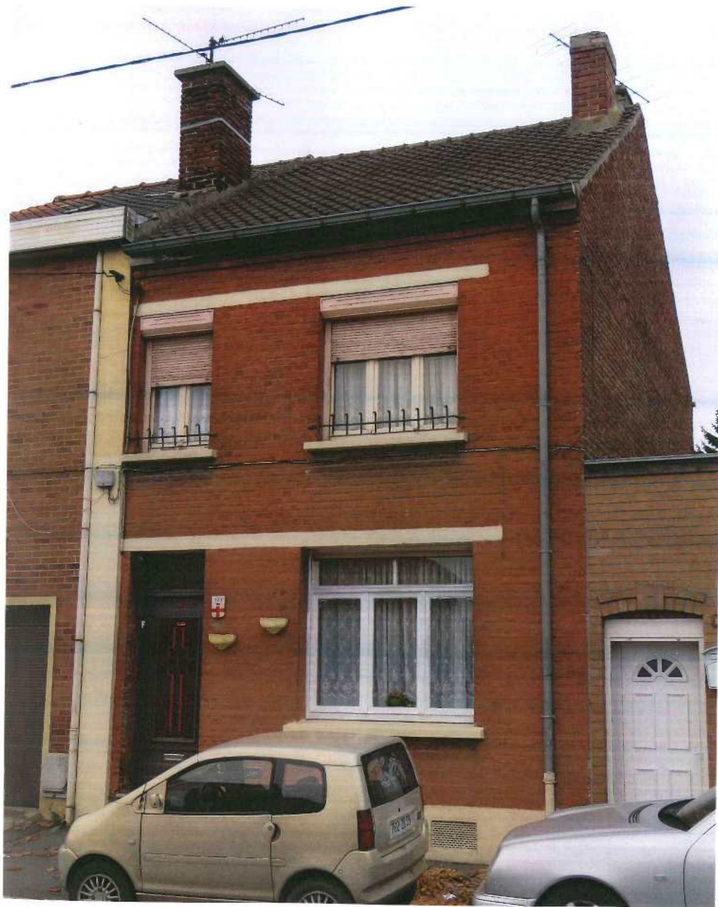
PV CREDIT FONCIER & COMMUNAL D'ALSACE LORRAINE - 10.11.2015 - Photo N° 2
