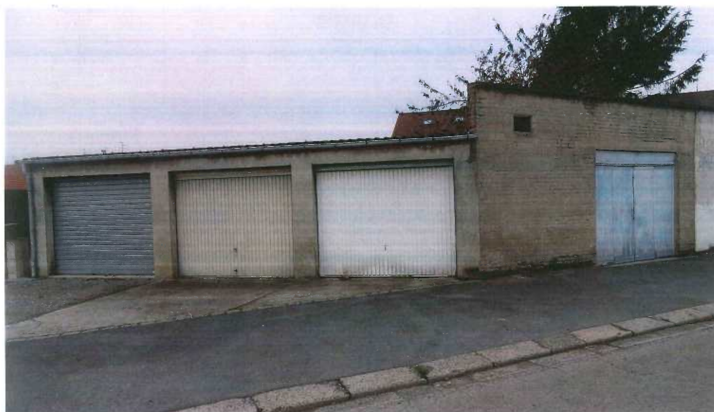
PV CREDIT FONCIER & COMMUNAL D'ALSACE LORRAINE - 10.11.2015 - Photo N° 25
