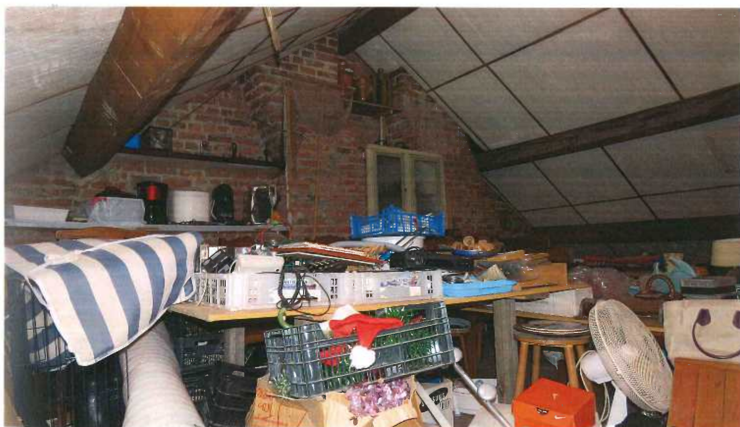
PV CREDIT FONCIER & COMMUNAL D'ALSACE LORRAINE - 10.11.2015 - Photo N° 22
