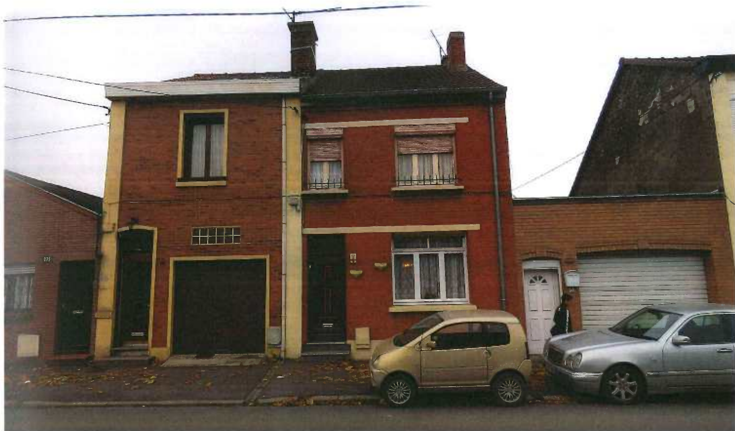
PV CREDIT FONCIER & COMMUNAL D'ALSACE LORRAINE - 10.11.2015 - Photo N° 5
