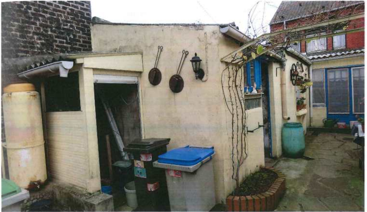
PV CREDIT FONCIER & COMMUNAL D'ALSACE LORRAINE - 10.11.2015 - Photo N° 7
