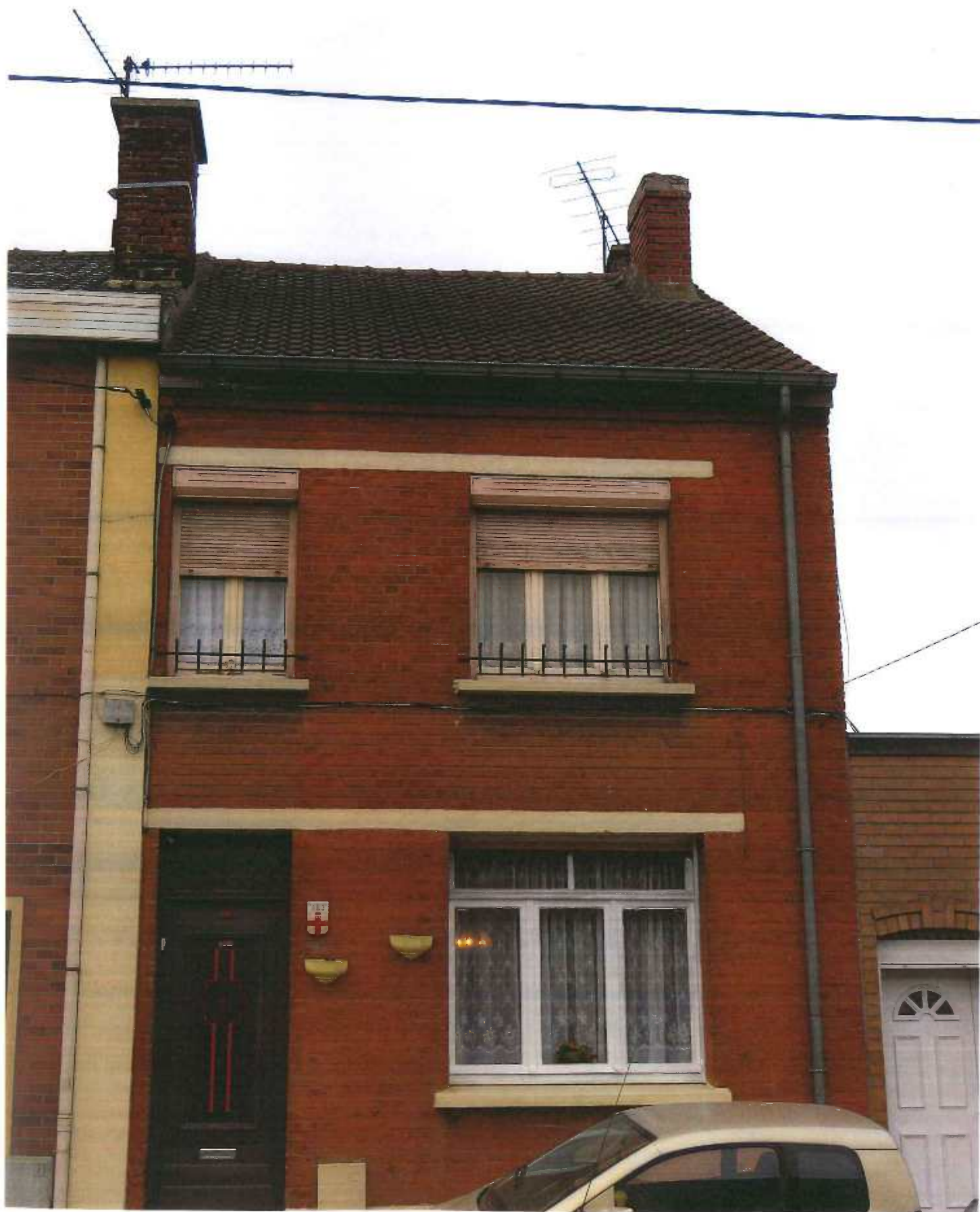
PV CREDIT FONCIER & COMMUNAL D'ALSACE LORRAINE - 10.11.2015 - Photo N° 1
