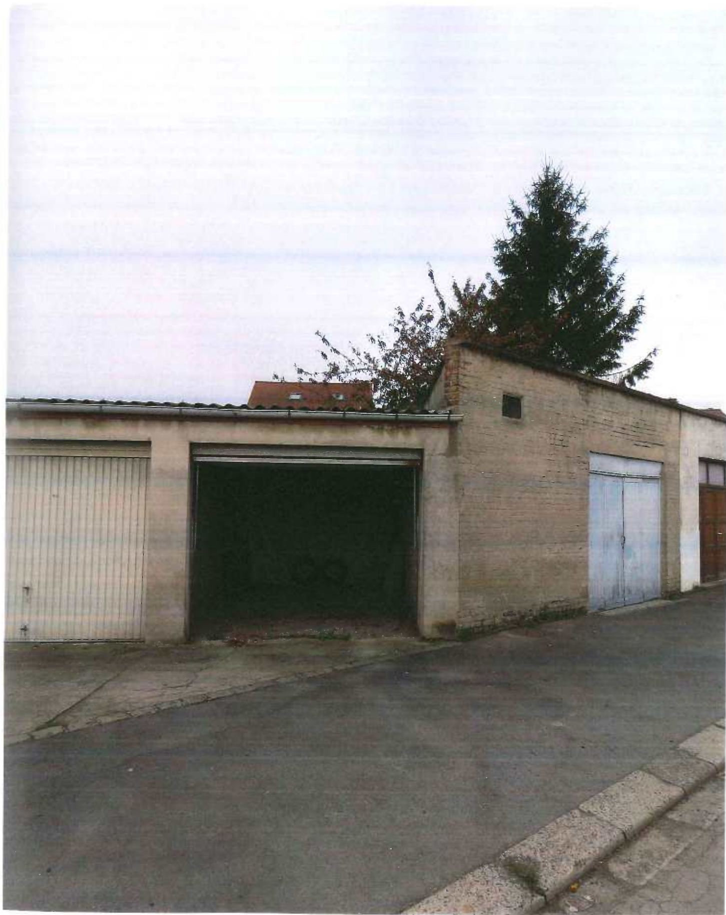
PV CREDIT FONCIER & COMMUNAL D'ALSACE LORRAINE - 10.11.2015 - Photo N° 23
