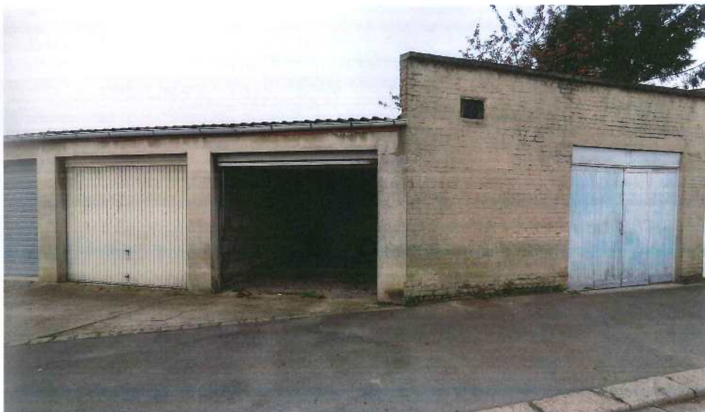
PV CREDIT FONCIER & COMMUNAL D'ALSACE LORRAINE - 10.11.2015 - Photo N° 24
