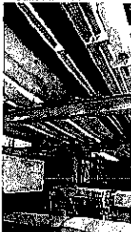
Composant : Calorifugeage 10 (N) laine de roche dans enveloppe PVC formeuse carton
