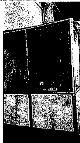
Composant : Panneaux rigides (cloisons, gaines, plafonds) 13 (N) panneau bois cloisons et plafond préfabriqué local sous trémie charbon
