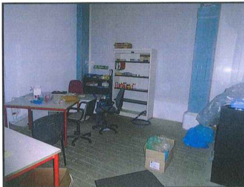
Bureau central avec vitrages donnant sur le couloir
