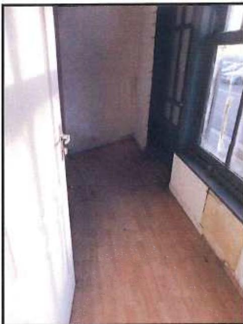
Cette pièce est éclairée par des menuiseries extérieures en façade avant, en bois avec simple vitrage, le tout vétuste.
