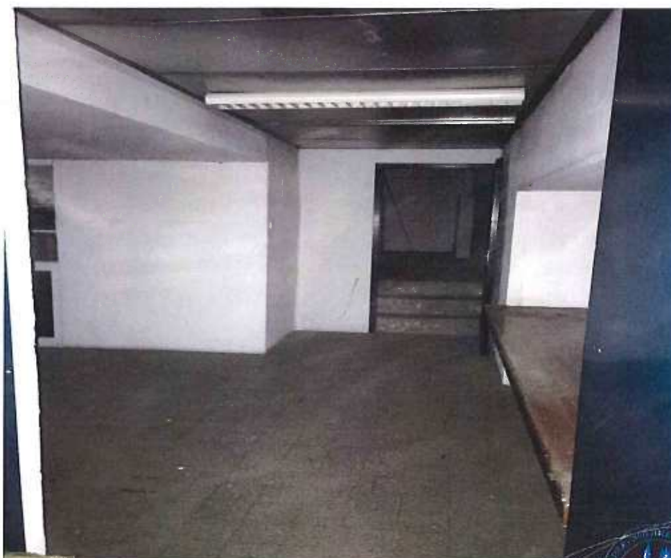
→ Hall de fabrication (P17)
