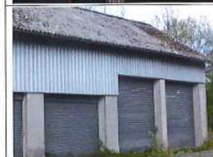
Photo n° PhA010 Localisation : REZ DE CHAUSSEE - Toitures P32-33-34-35-36 Ouvrage : Plaques ondulées Partie d'ouvrage : Plaques en fibres-ciment Description : Plaques en fibres-ciment
